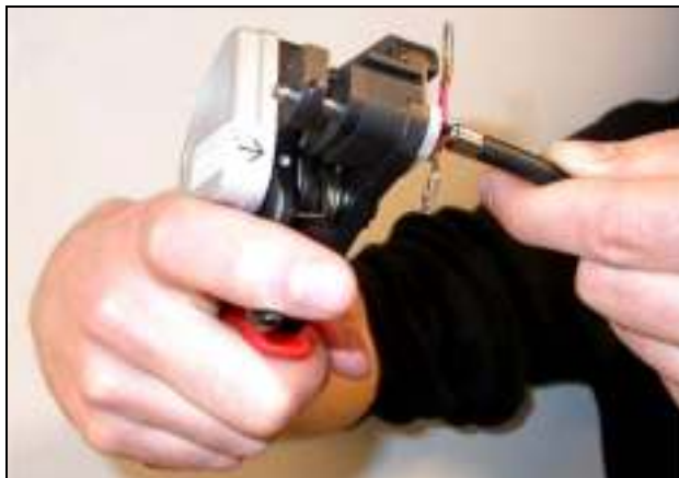
рисунок 30.17: Обрезка оптоволокна (3)
